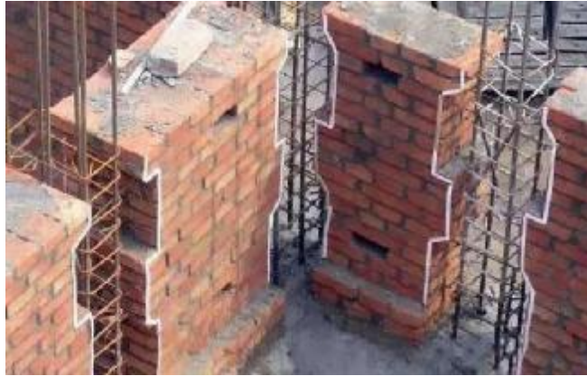
图 1 构造柱砌体马牙槎留置
